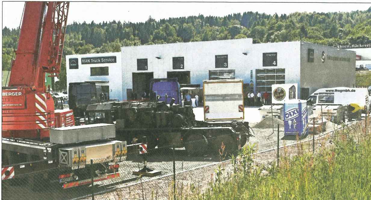
Die große Technikausstellung vor der am Freitag eingeweihten Werkstatthalle der Fahrzeughandel und Service GmbH (FHS) wird auch an diesem Wochenende noch zu sehen sein. Samstag und Sonntag finden Tage der offenen Tür im Neubau direkt an der B 62 statt.
